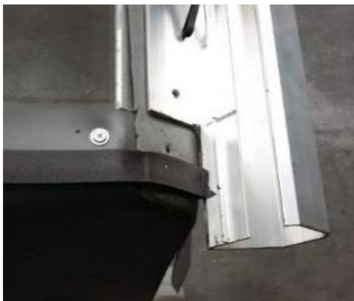
Rys. 64 Przykład podjęcia profilu krawędziowego
